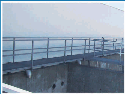
Nave de control y depósitos en fase de construcción
